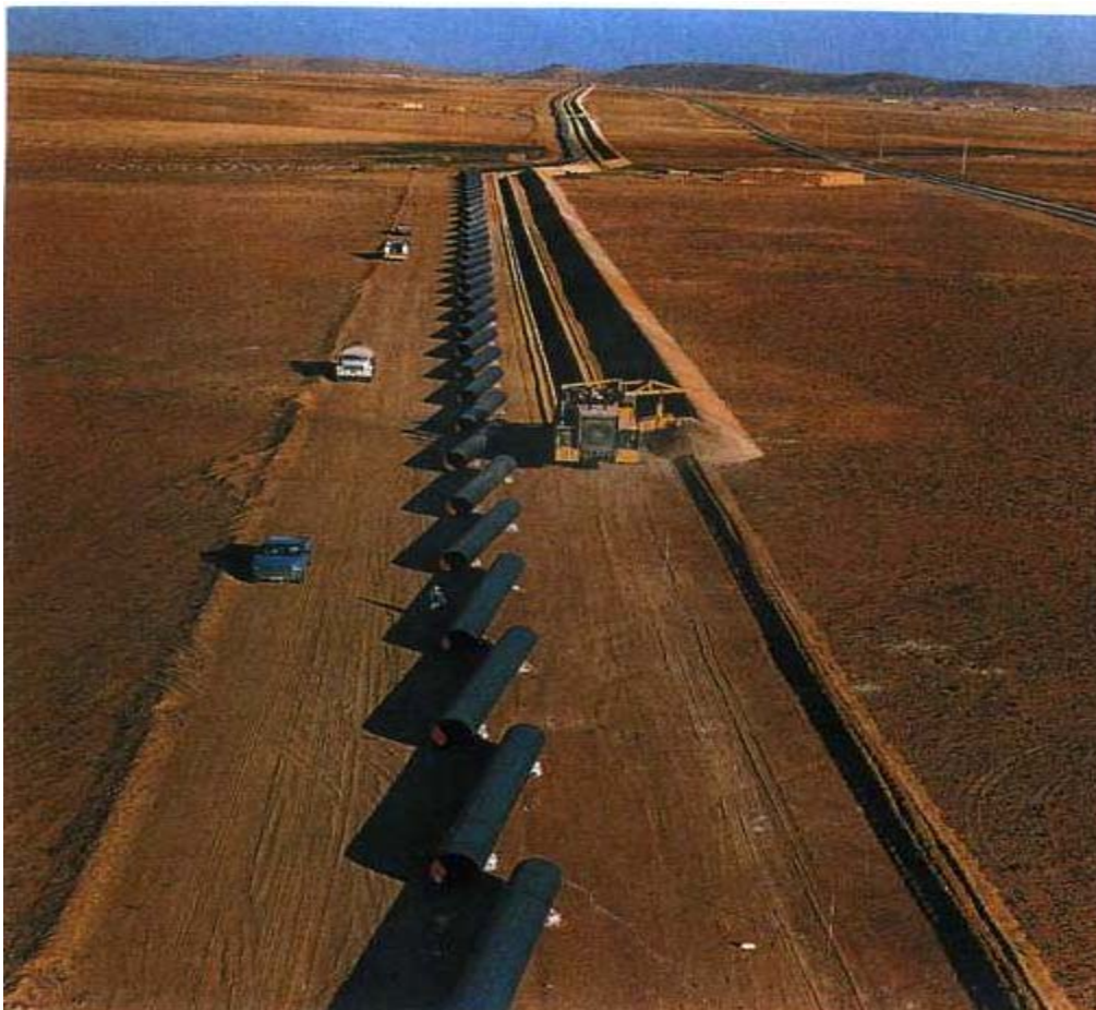
Figura 1. Tubería distribuida y excavación de zanja
