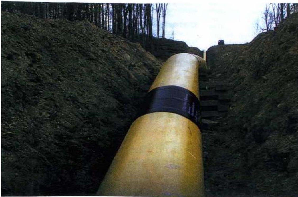
Figura 4. Tubería en zanja. Revestimiento de juntas
