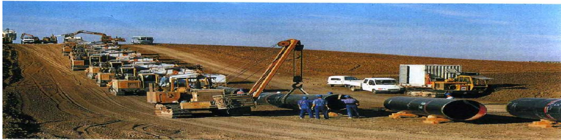
Figura 2. Tren de Soldadura
